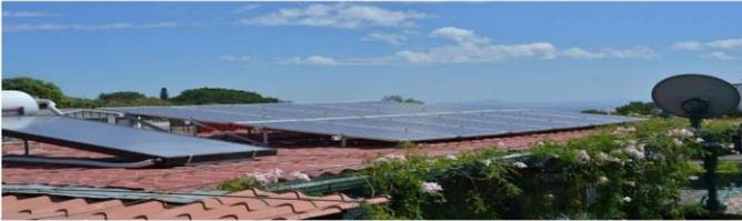
**Figura 1:** Vivienda con sistema de paneles fotovoltaicos, el 40% de la energía proviene del sistema fotovoltaico.
